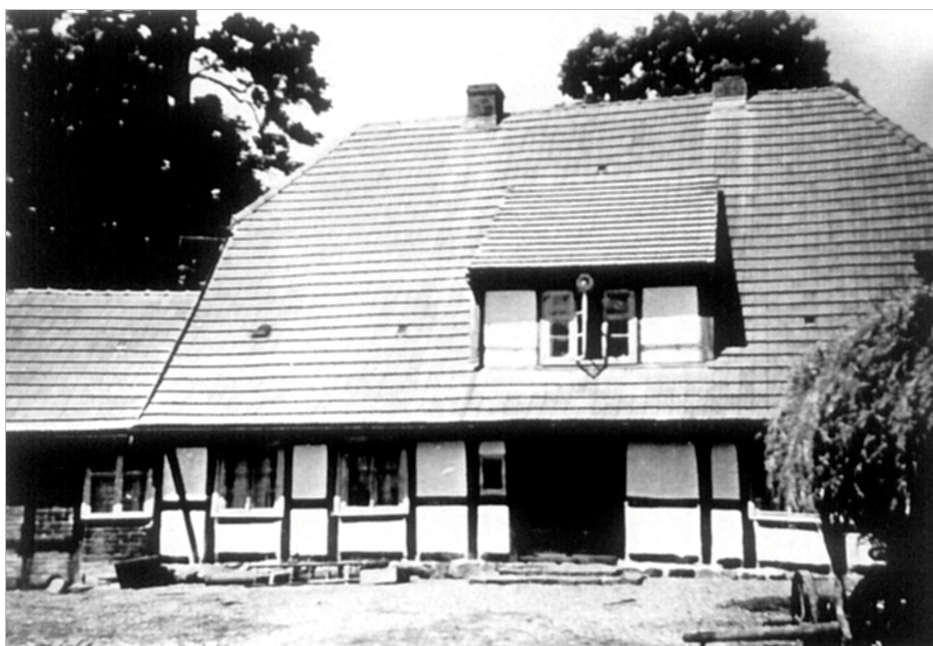
Ryc. 21. Budynek mieszkalny w zagrodzie nr 16 po modernizacji w 1937 roku
